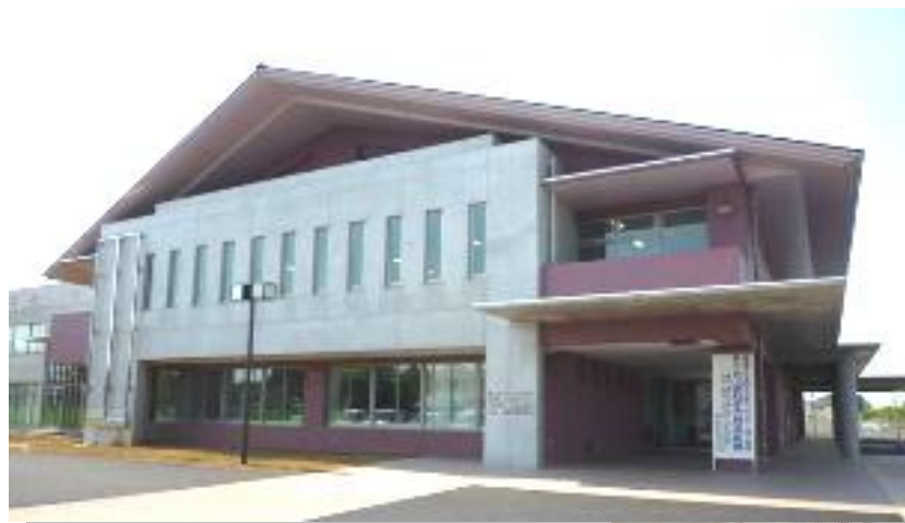
▲ 大野ふれあいセンター外観 2階手前部分が大野分館
