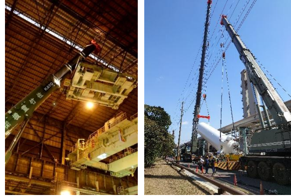
【300 t オールテレーンクレーン】
