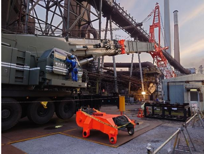
【550 t オールテレーンクレーン】
