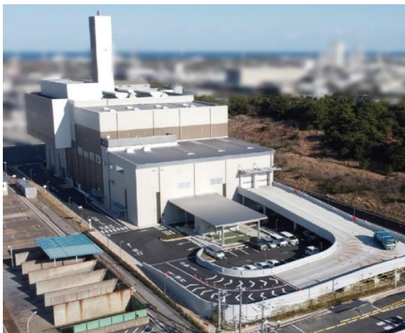
■ 鹿島可燃ごみ共同クリーンセンター 令和6年4月1日稼働
