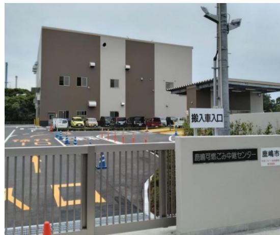
■ 鹿嶋可燃ごみ中継センター 令和6年7月1日稼働
