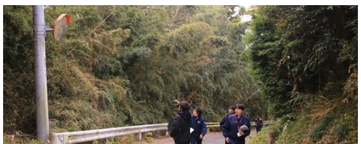
▲市道0153線下り坂にあるカーブミラーの角度や汚れを確認
