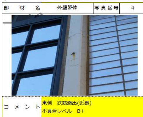
■ 図 3-4 鹿嶋市公共建築物における外壁の損傷写真（平成 28 年 12 月点検試行結果）
