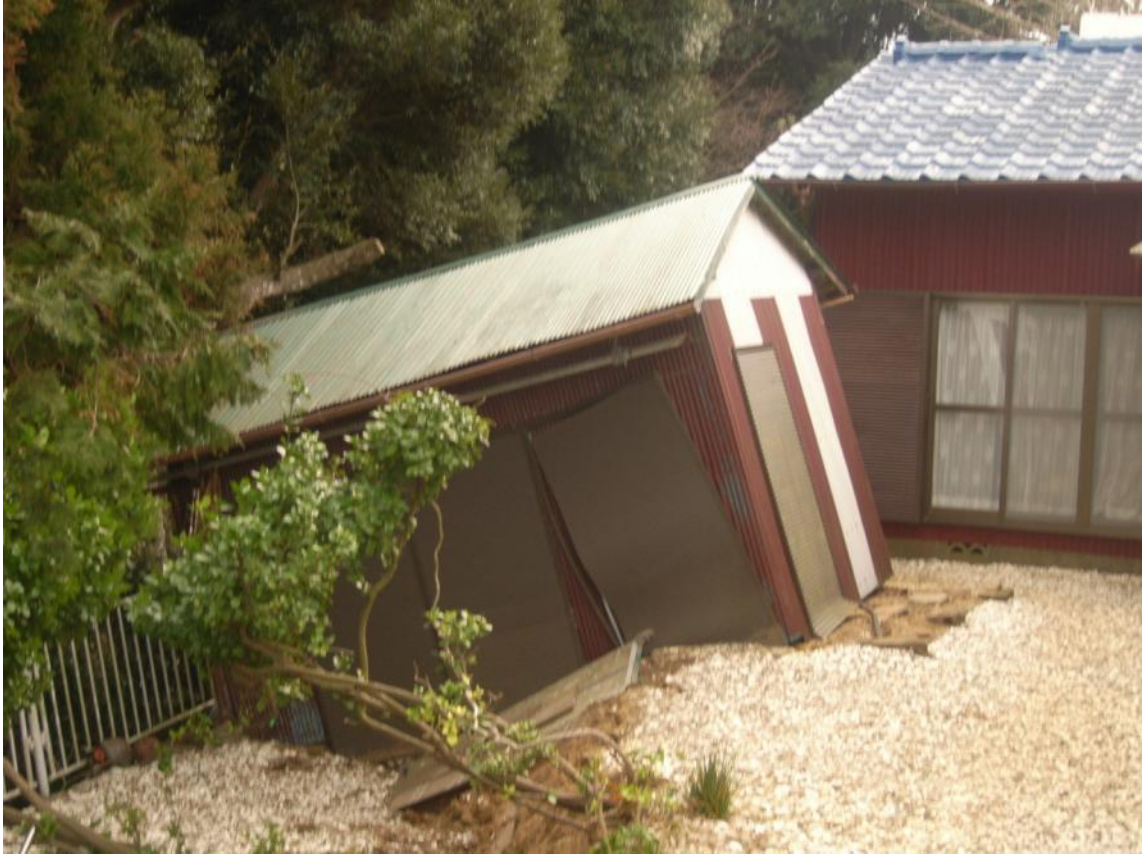
がけ崩れによる建物の倒壊 〈大野消防署提供〉
