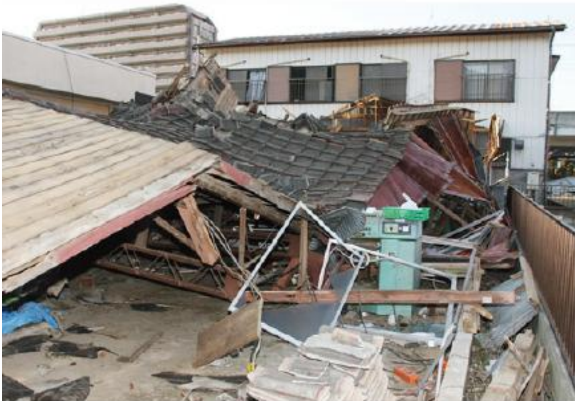
全壊した建物
