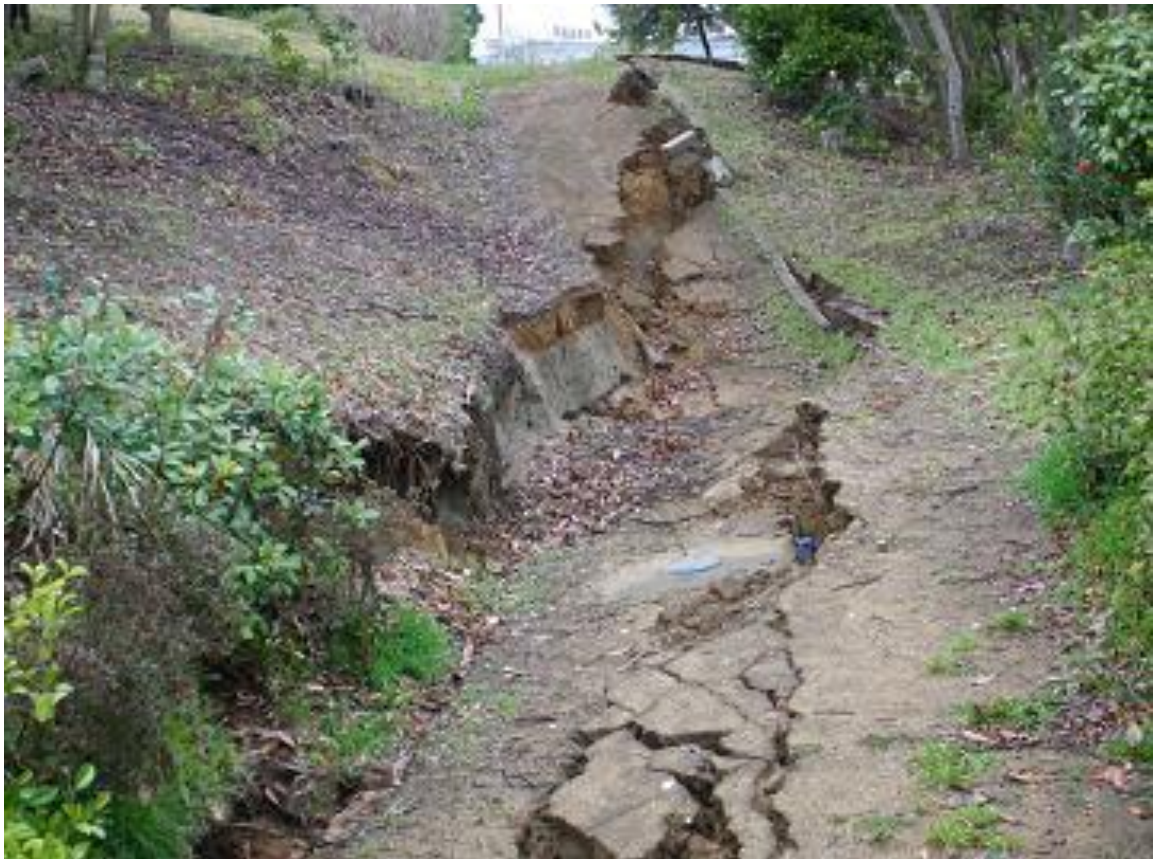
公園内の地盤の崩壊
