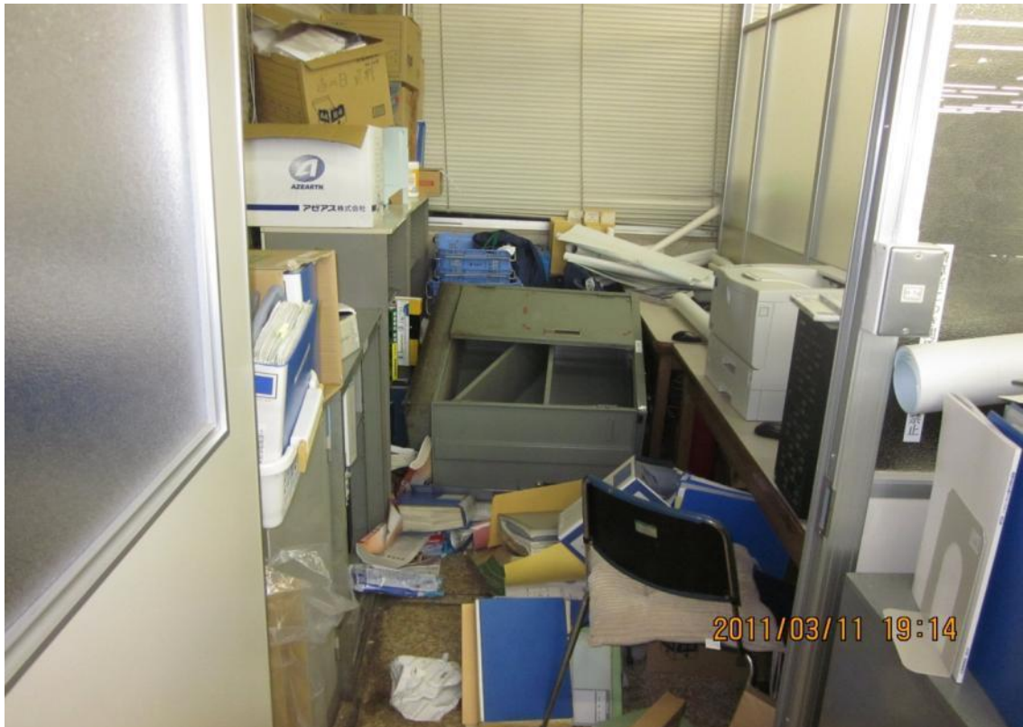
什器等の散乱（鹿嶋市役所 1階）
