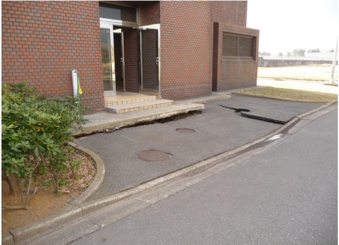
液状化による地盤沈下（浄化センター）
